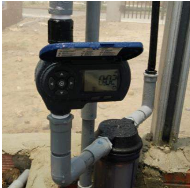
Hệ thống hẹn giờ tưới tự động
